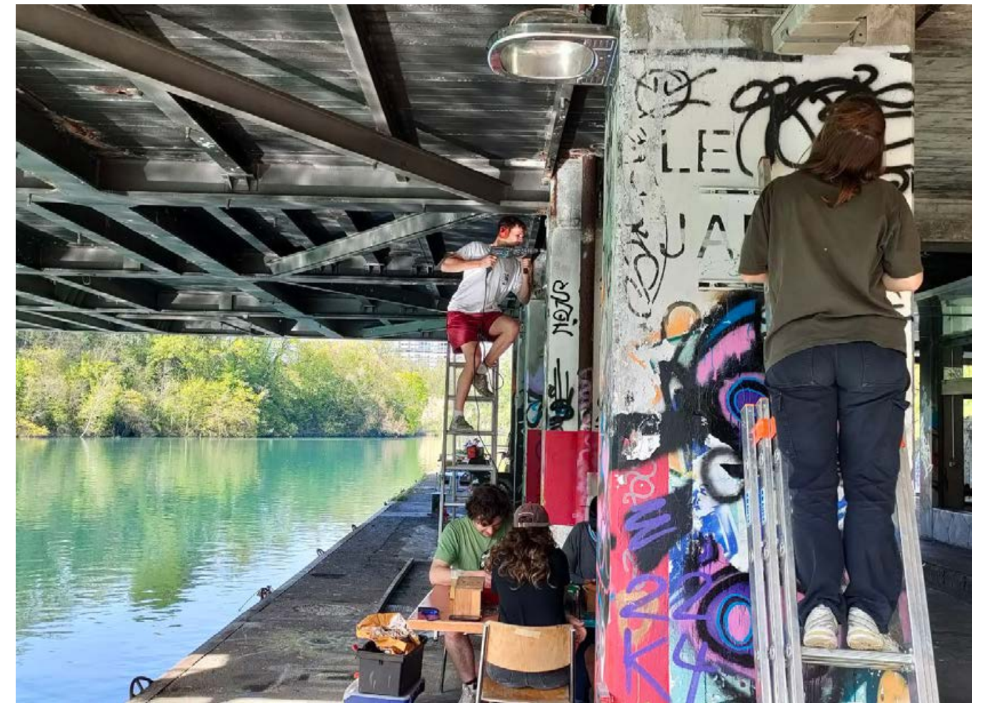
Fig. 40 - Chantier participatif sous le porte-à-faux (2024)
