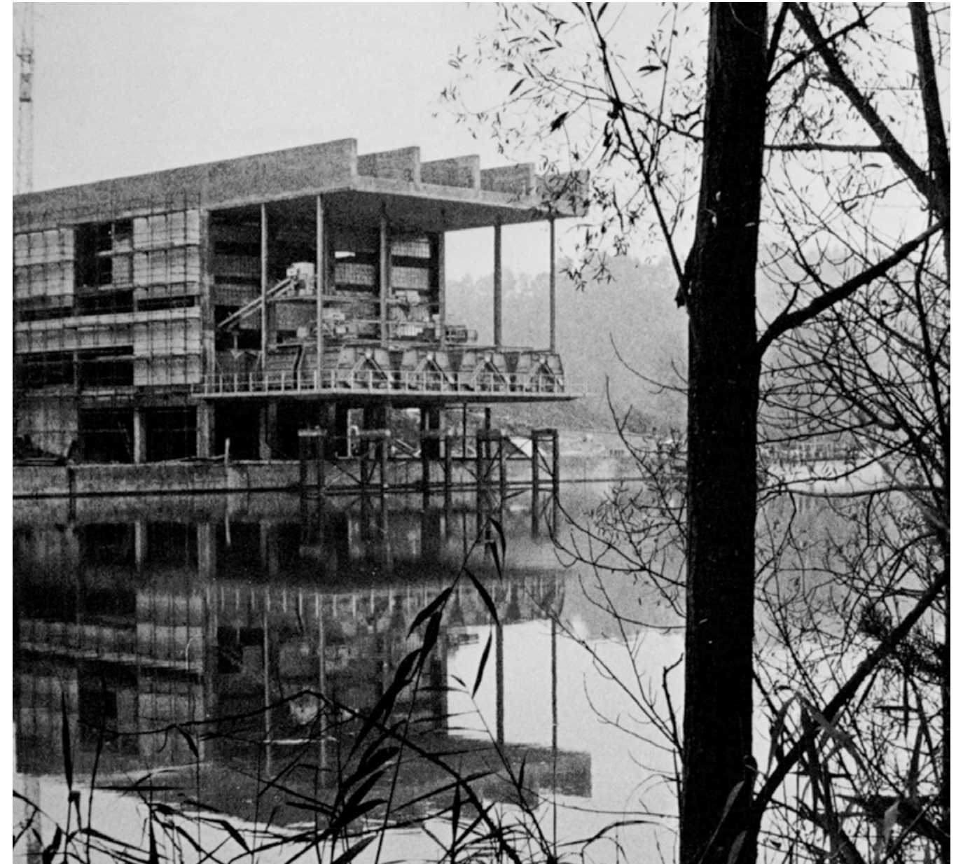
Fig. 13 - Le bâtiment en construction vu depuis la rive gauche du Rhône (1966)
